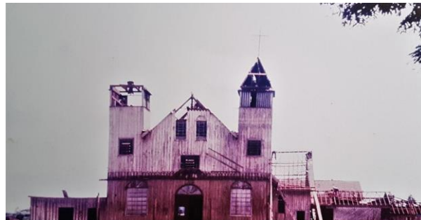
Figura 2: demolição da catedral de Maringá-PR 19
