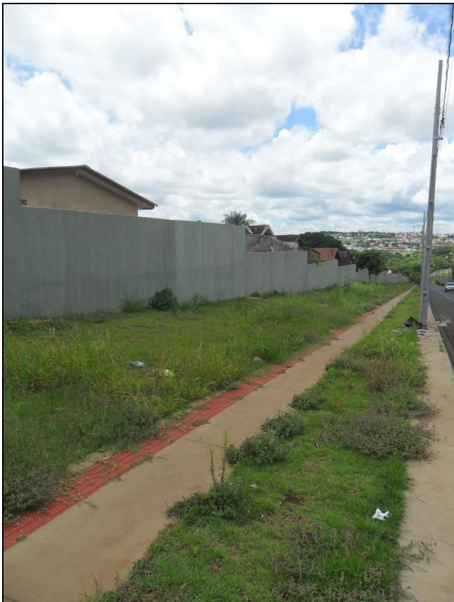
Figura 26 - Muro construído entre CHSF e Avenida Cerro Azul
