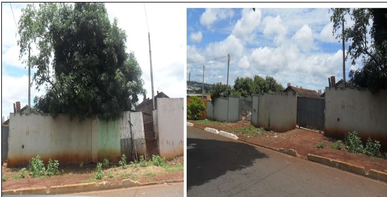
Figura 24 - Terrenos sem calçamento, 2018 (1)
