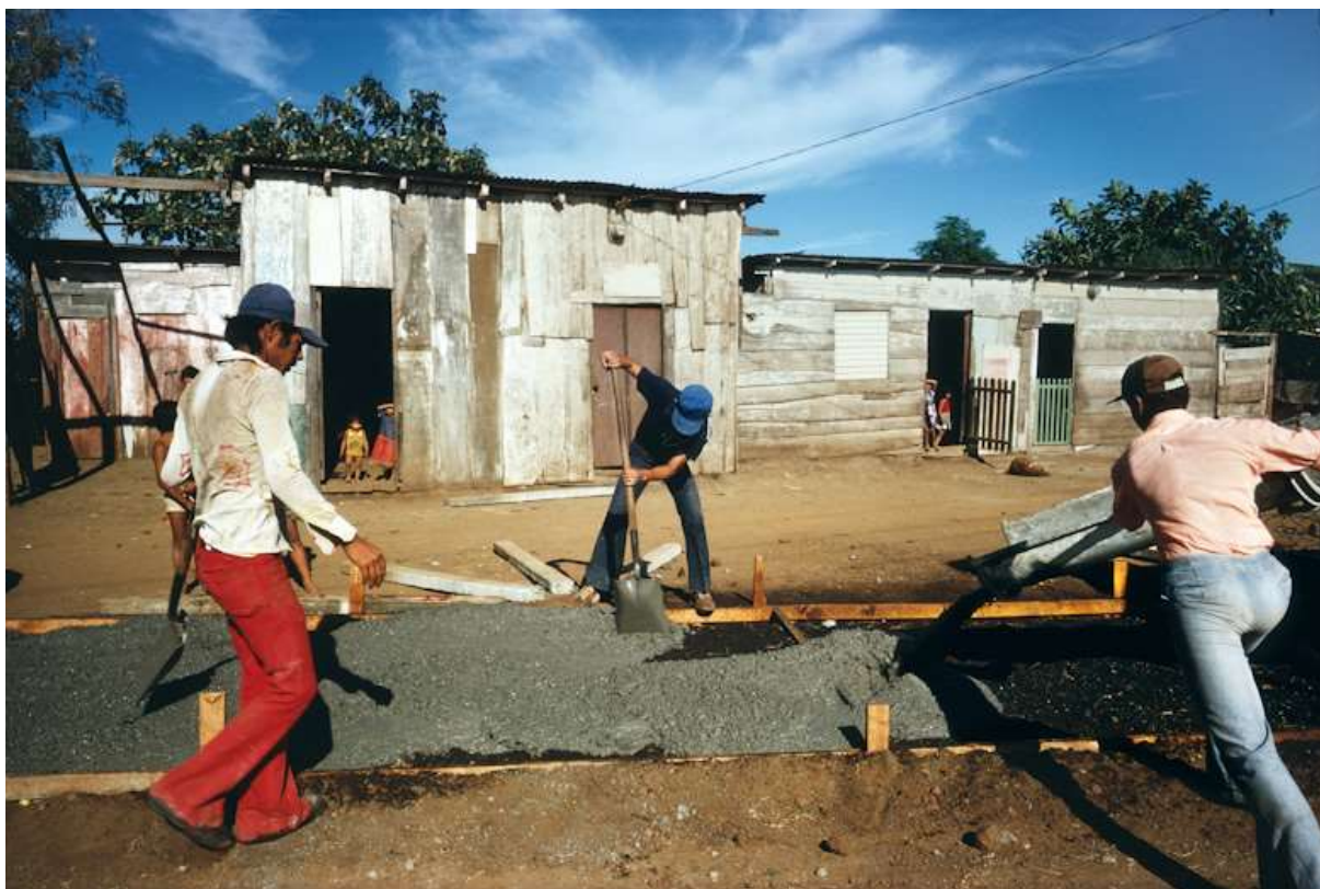
Figura 5. Construção de calçada em Manágua, 1979.
