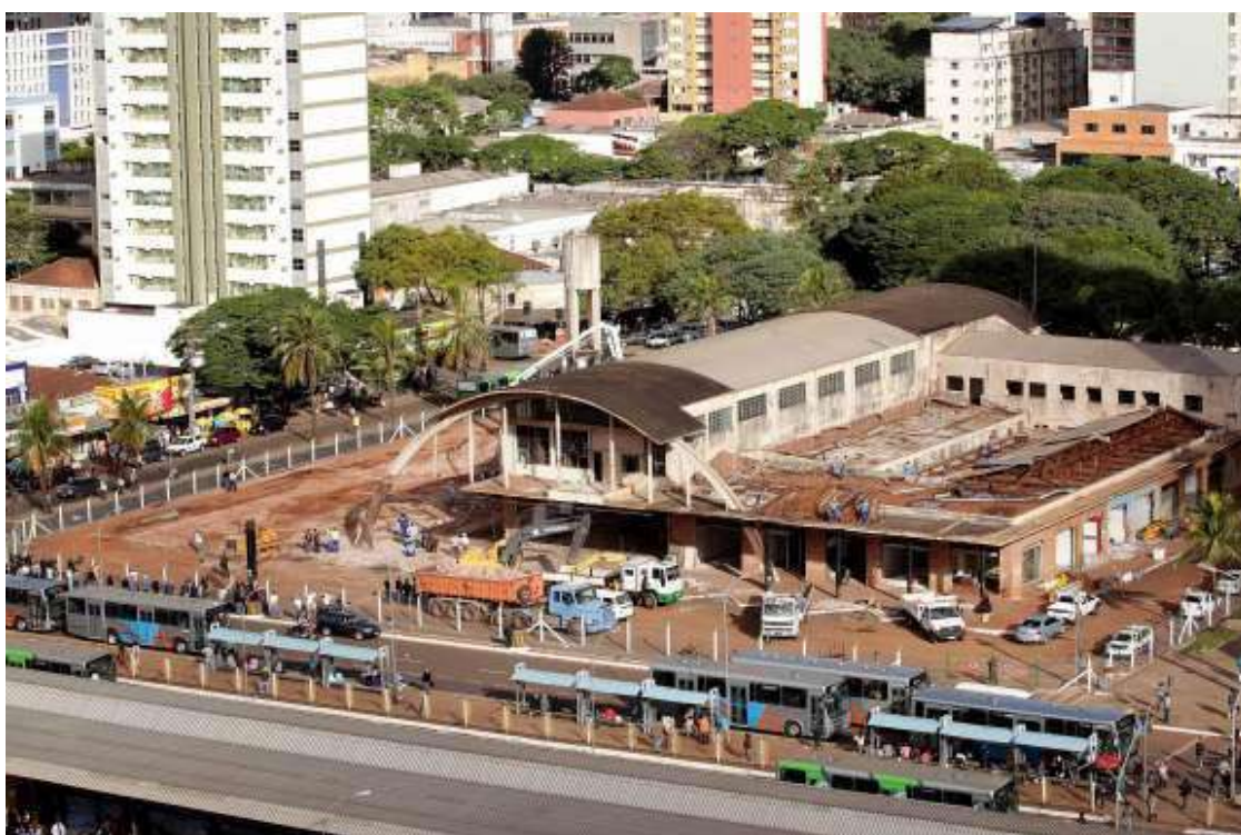
Figura 21: A Antiga Rodoviária parcialmente demolida, em 2010
