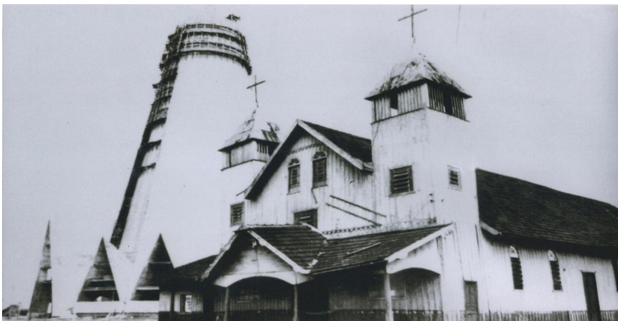
Foto 4: Ao lado da antiga Catedral, a construção do novo templo. Fonte: Kenji Ueta.
