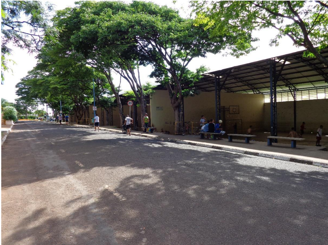
Figura 6 – Parte da área externa do ginásio poliesportivo “Pedro Morilla Fuentes” (Pedrocão). Fonte: o autor (2015).
