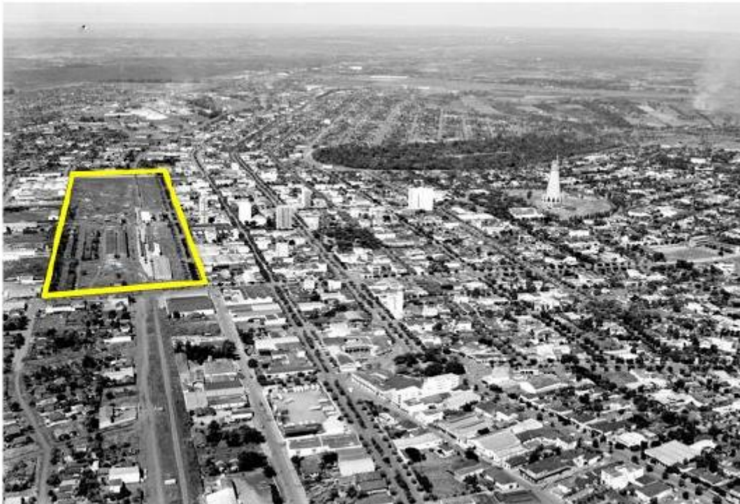
Figura 4: Estação Ferroviária e pátio de manobras em destaque. Maringá, década de 1970. Fonte: FERREIRA; CORDOVIL; VERRI JÚNIOR, 2013.
