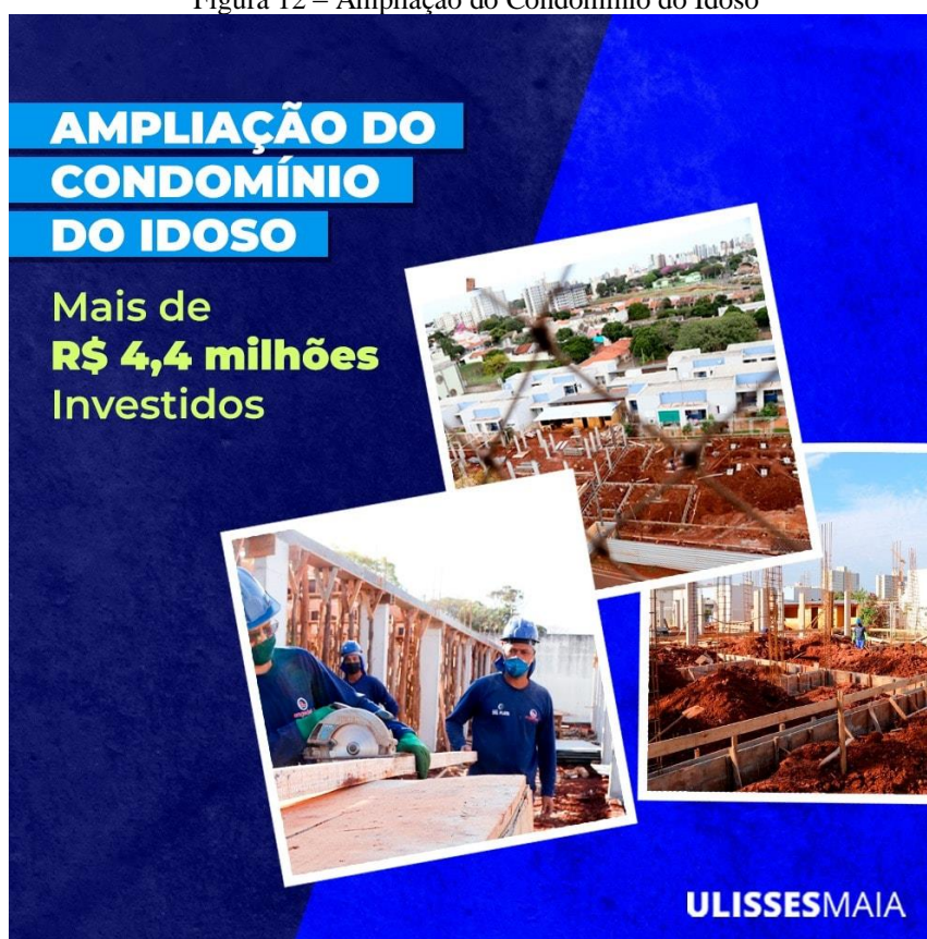
Figura 12 – Ampliação do Condomínio do Idoso
