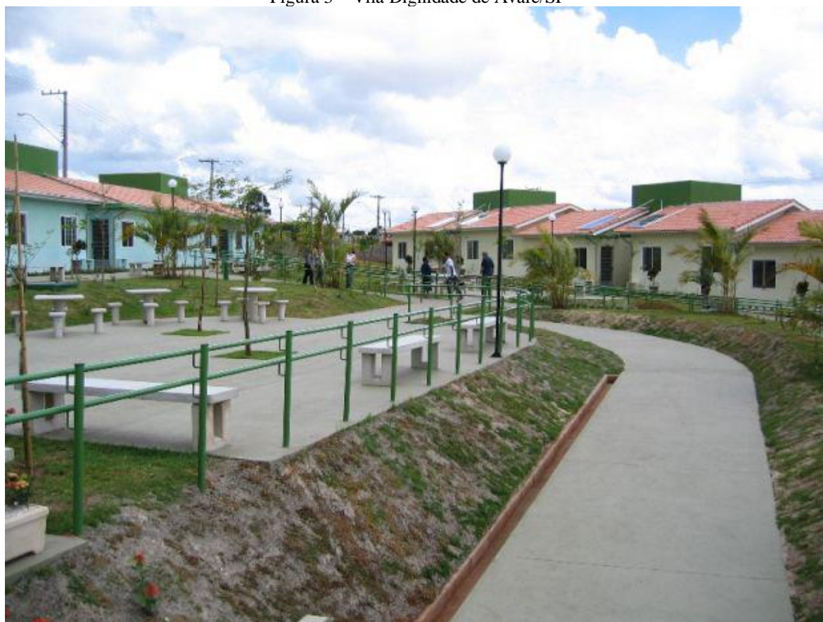
Figura 3 – Vila Dignidade de Avaré/SP
