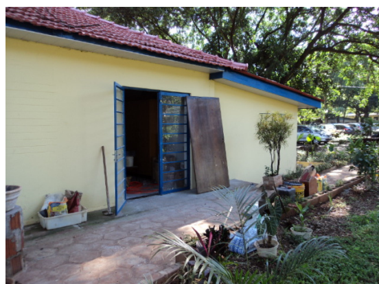
Fachada da entrada da oficina
