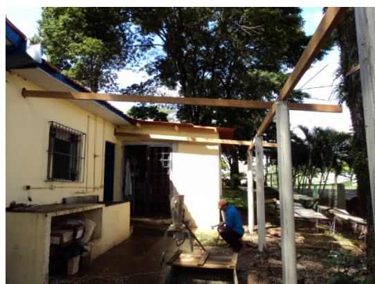
Fachada da entrada da oficina
