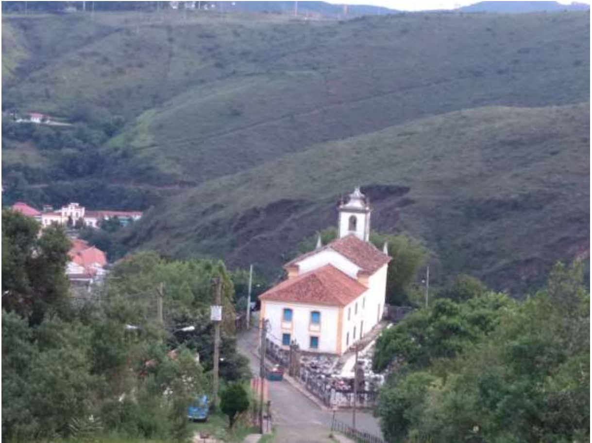
Figura 21 - Vista da Igreja de São José, Ouro Preto-MG 05/01/19
